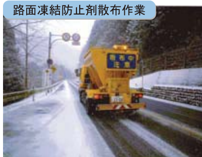
路面凍結防止剤散布作業
