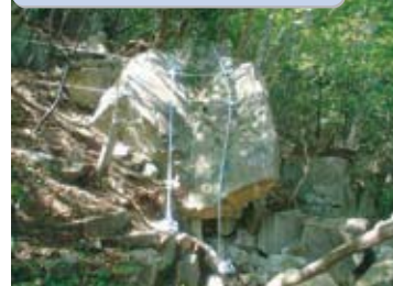
岩塊の対策工事
