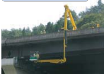
橋梁点検車による定期点検
