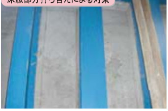
床版部分打ち替えによる対策
