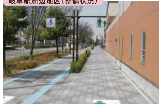
岐阜駅周辺地区（整備状況）
