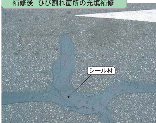
補修後 ひび割れ箇所の充填補修
