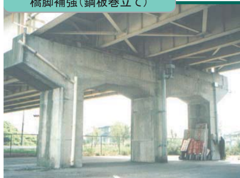
橋脚補強(鋼板巻立て)
