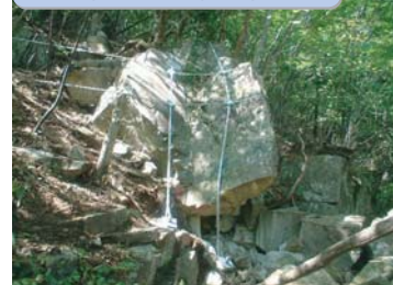
岩塊の対策工事
