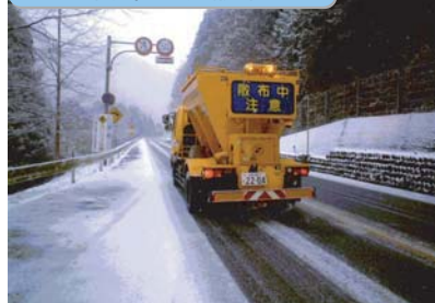
路面凍結防止剤散布作業
