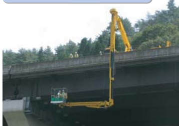
橋梁点検車による定期点検
