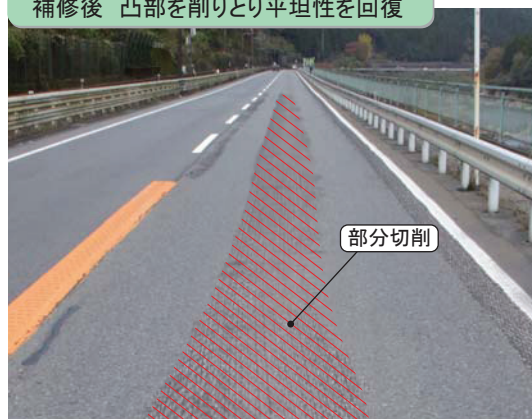
補修後 凸部を削りとり平坦性を回復
