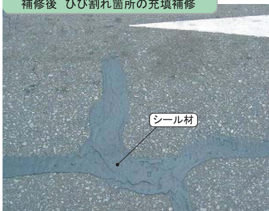
補修後 ひび割れ箇所の充填補修
