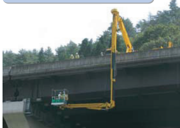
橋梁点検車による定期点検
