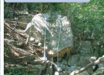
岩塊の対策工事
