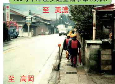
156号中津屋歩道整備事業(現状)
