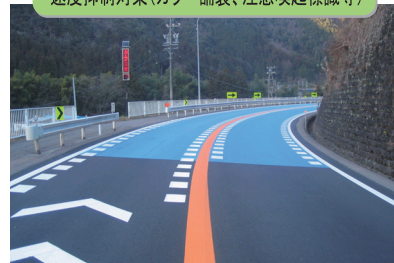
速度抑制対策(カラー舗装、注意喚起標識等)
