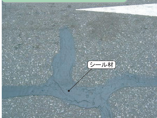
補修後 ひび割れ箇所の充填補修
