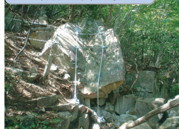
岩塊の対策工事
