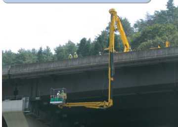
橋梁点検車による点検
