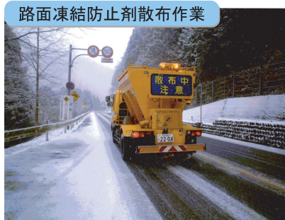
路面凍結防止剤散布作業
