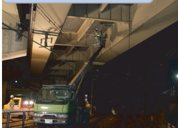
リフト車による跨線橋の点検
