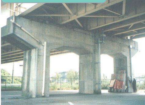
橋脚補強(鋼板巻立て)
