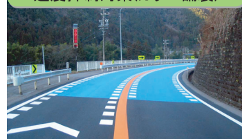
速度抑制対策(カラー舗装)
