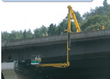
橋梁点検車による点検
