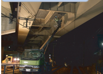
リフト車による跨線橋の点検
