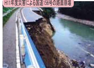
H11年度災害による国道156号の路面崩壊
