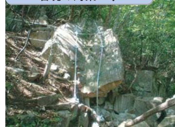
岩塊の対策工事
