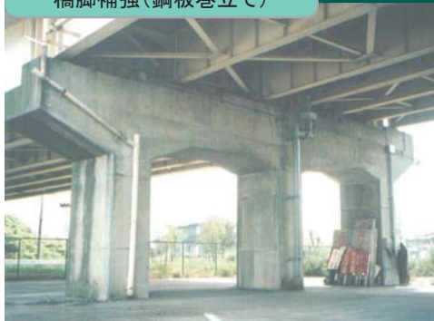
橋脚補強(鋼板巻立て)
