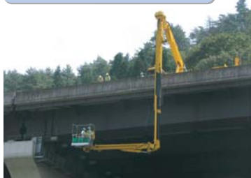
橋梁点検車による点検
