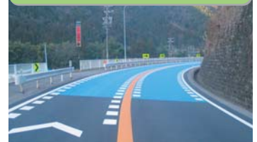
速度抑制対策(カラー舗装)
