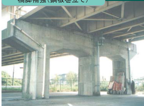
橋脚補強(鋼板巻立て)
