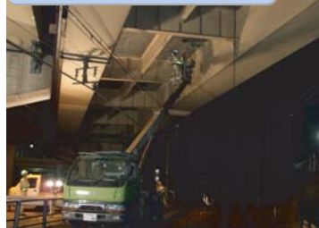
リフト車による跨線橋の点検
