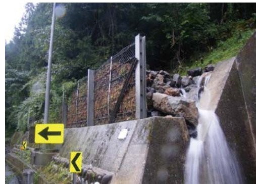
斜面からの落石や土砂が国道41号に到達し路面を塞いだ状況など(平成23年9月20日)
