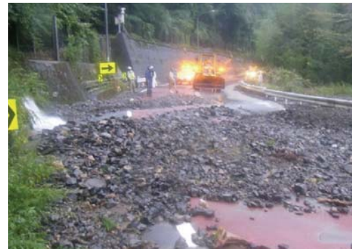
斜面からの落石や土砂が国道41号に到達し路面を塞いだ状況など(平成23年9月20日)
