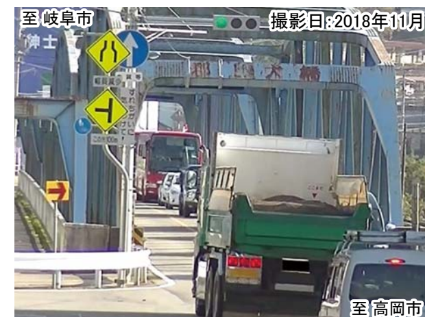
写真2 対向大型車の通過待ち状況
