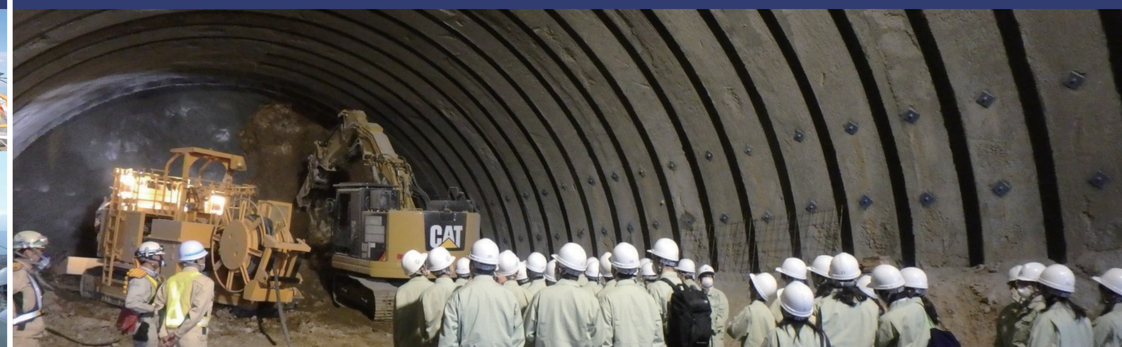
国道475号 東海環状自動車道 トンネル工事(山県第一トンネル(仮称))などの見学
