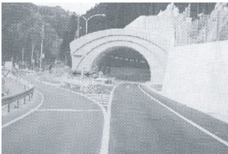
名津佐トンネル部供用(平成6年)
