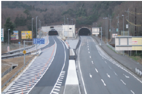
岩戸トンネル完成
