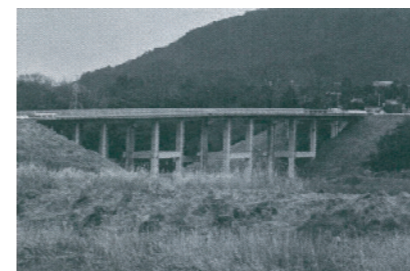
258号駒野高架橋
