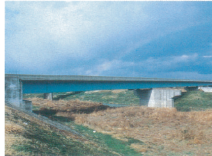
S49 258号養老大橋完成
