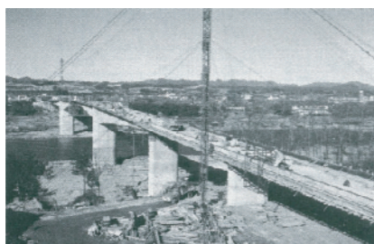
中濃大橋ディバダーク方式 3径間有鉸ラーメン箱桁橋
