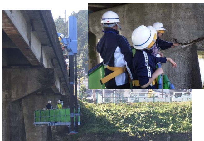
橋梁点検車の試乗体験
