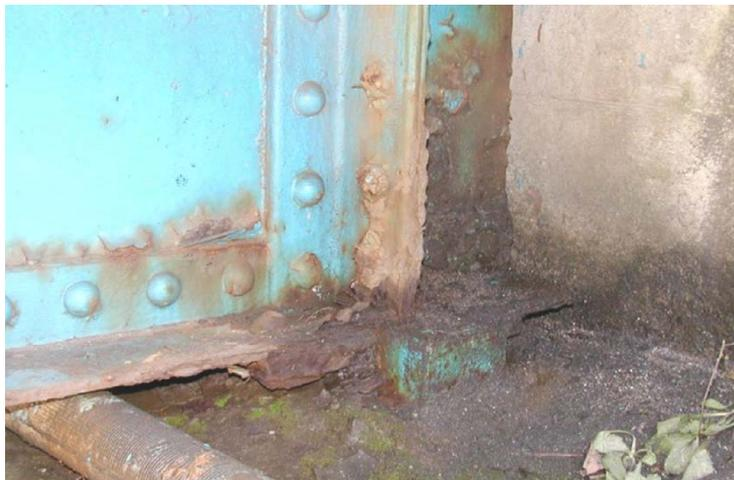
支点の鋼材も腐食している
