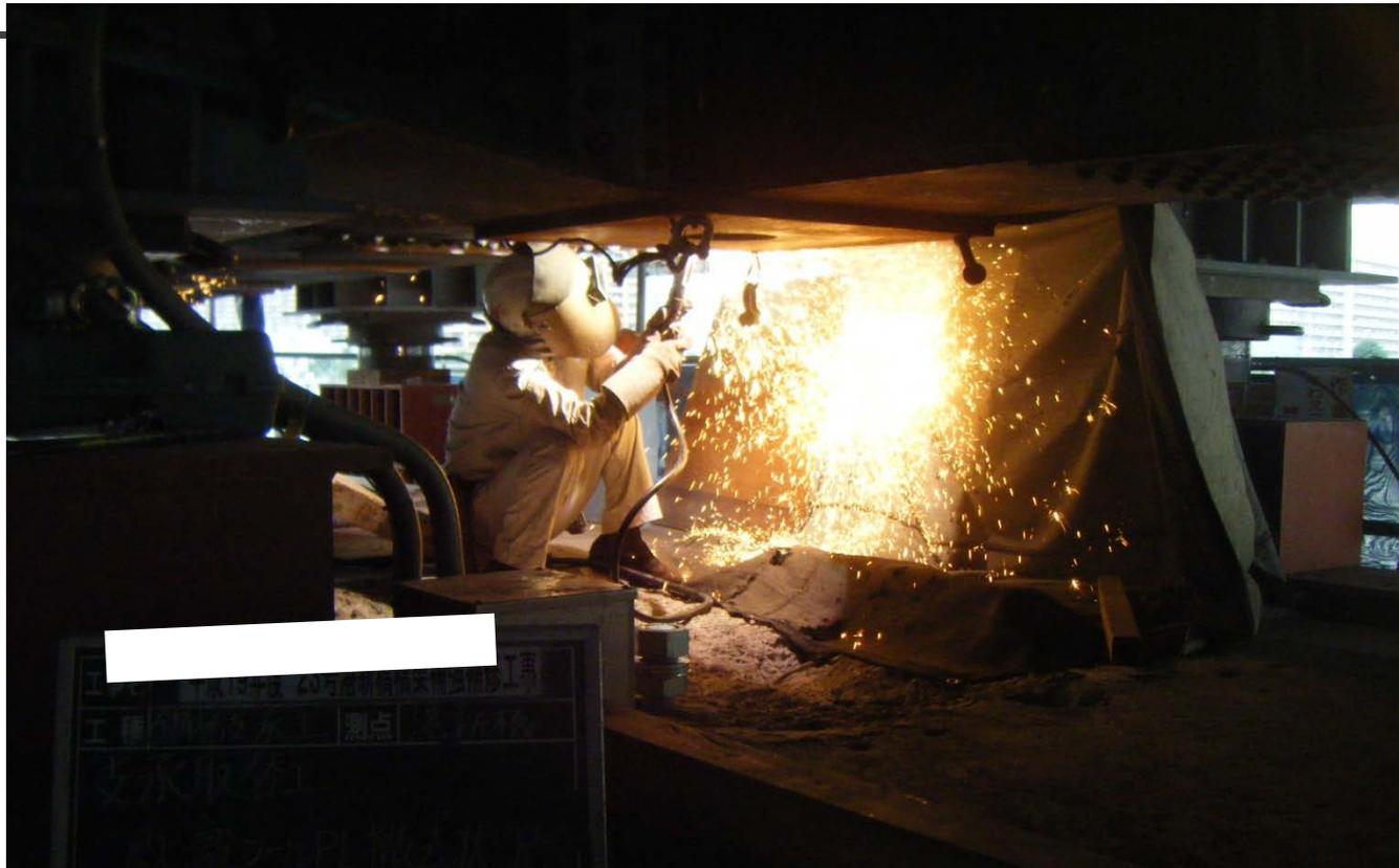
ガウジングにより既設ソールPLの溶接ビードを飛ばし
