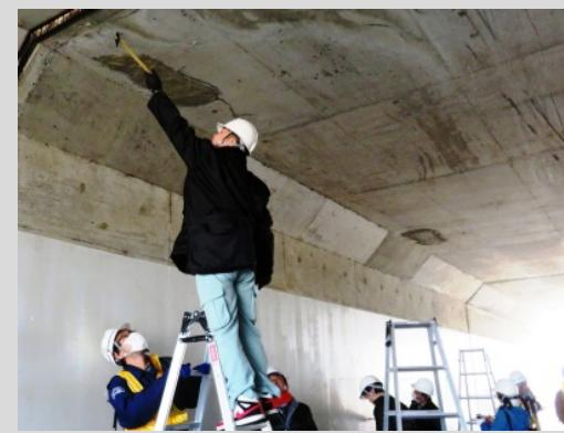
打音検査の様子（函渠）
