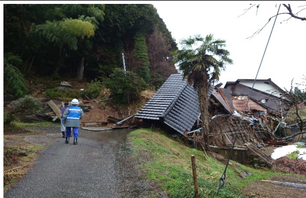
石川県輪島市縄又町 被災状況の調査
