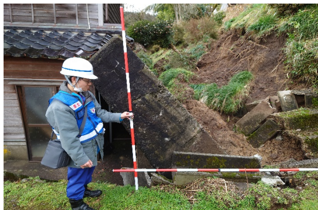
石川県輪島市房田町 被災状況の調査
