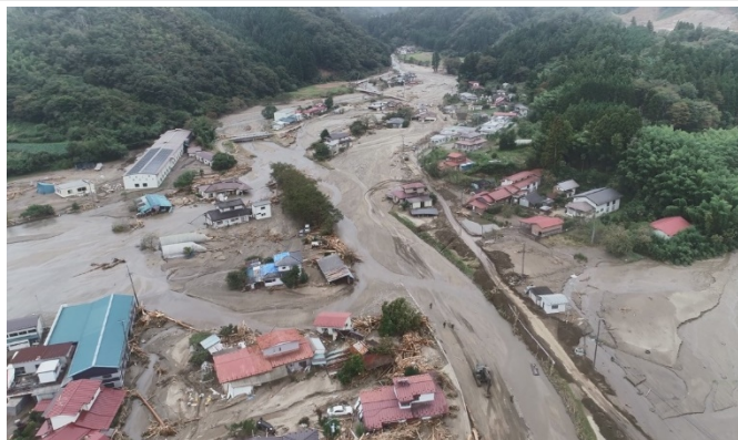
令和元年10月18日 丸森町被災状況調査(ドローンからの撮影)
