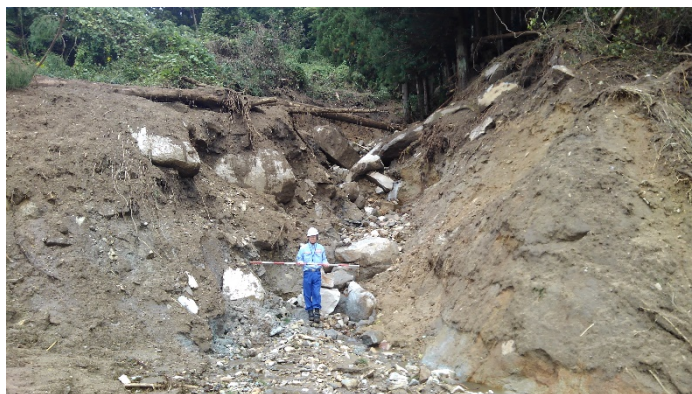
令和元年10月20日 丸森町被災状況調査(土石流発生箇所の状況)
