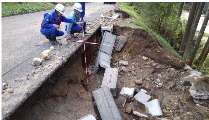
令和元年10月17日 丸森町被災状況調査
