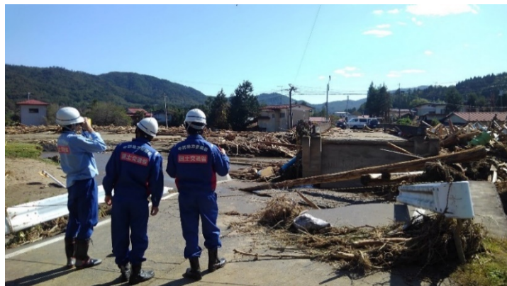
令和元年10月16日 丸森町被災状況調査
