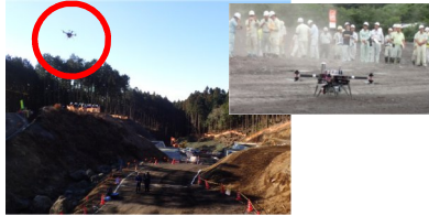
ドローンをを用いた起工測量状況
