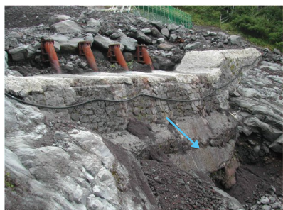
床固式低ダム工（昭和58年度施工）
