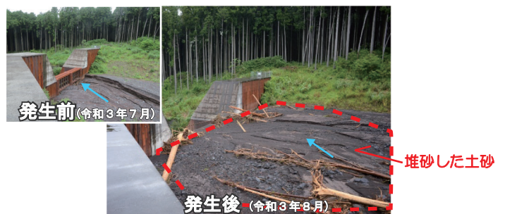
風祭第1砂防えん堤工
