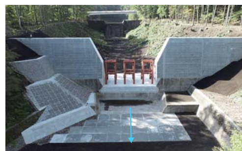
宮川7号砂防えん堤工(令和5年度完成)
