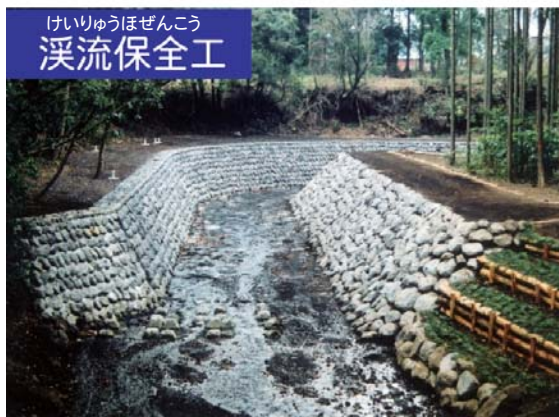
大久保沢溪流保全工
