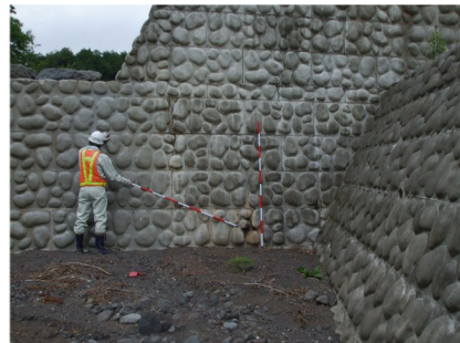
施設点検状況
