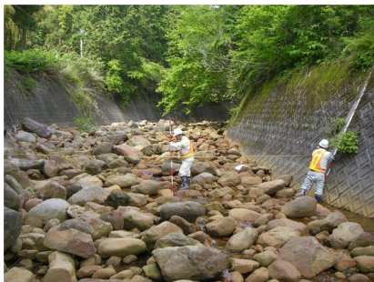
溪流点検状況
