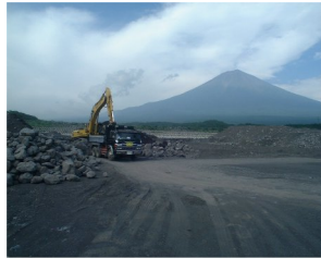
大沢川遊砂地工除石工事
