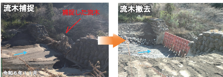
須津第1砂防えん堤工
