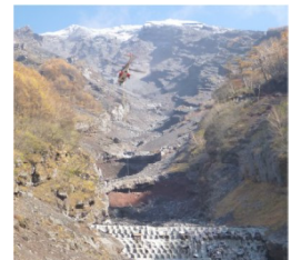
ヘリコプターを用いた施工状況
