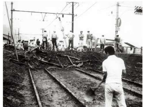
昭和49年 国鉄(JR)東海道本線 線路上に堆積した土砂の排出作業
