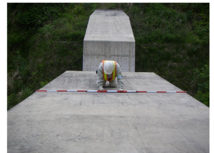
施設点検状況
