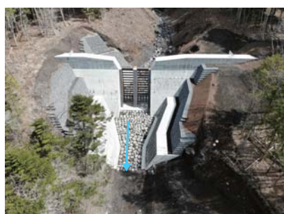
大久保第2砂防えん堤工(令和6年度完成)
