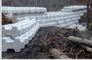
ブロック砂防えん堤工 (平成26年 御嶽山)
