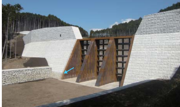
千束第5砂防えん堤工
