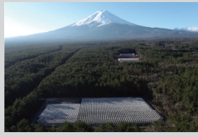
コンクリートブロック備蓄 (富士山)
