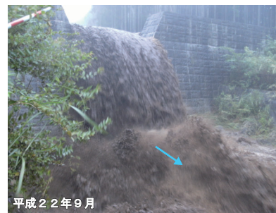
砂沢第1砂防えん堤工
