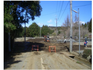
土砂流出による復旧作業
