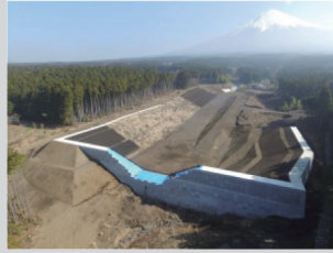
遊砂地工(沈砂地工) (富士山)
