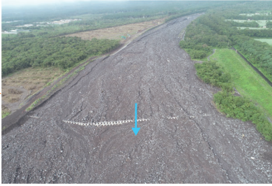
令和3年8月19日 土石流発生後
