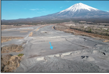
土石流発生前 第8上流床固工
