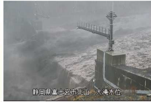
監視カメラがとらえた雪代(スラッシュ雪崩) (令和3年3月)
