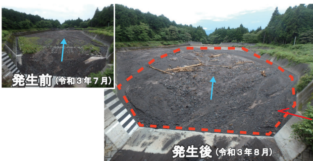
風祭沈砂地工
