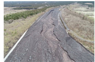
大沢川遊砂地工で氾濫した土石流 (UAVによる調査)
