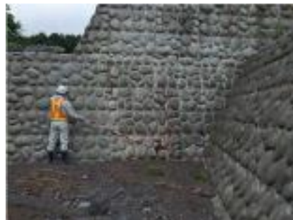
施設点検状況
