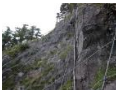
斜面对策工（平成14年度施工）
