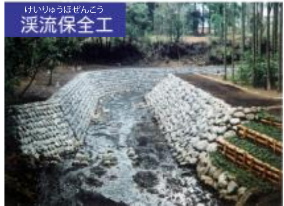
大久保沢渓流保全工
