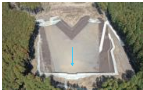
春沢遊砂地工(令和5年度完成)
