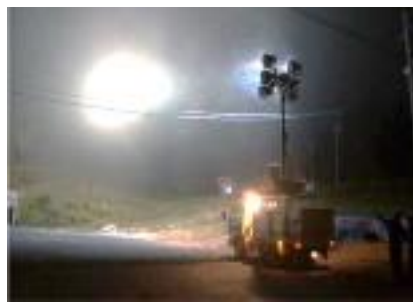
照明車による支援（御嶽山）
