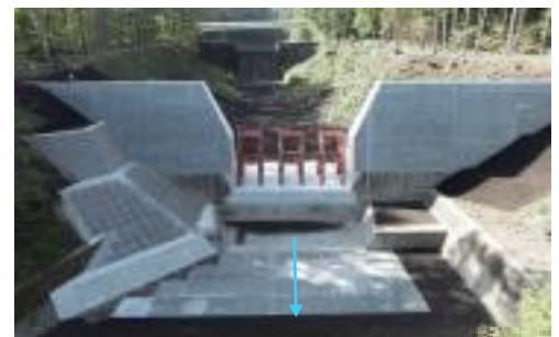
宮川7号砂防えん堤工(令和5年度完成)
