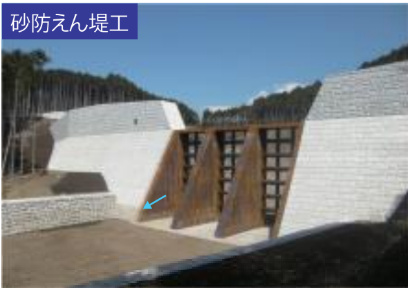
千束第5砂防えん堤工
