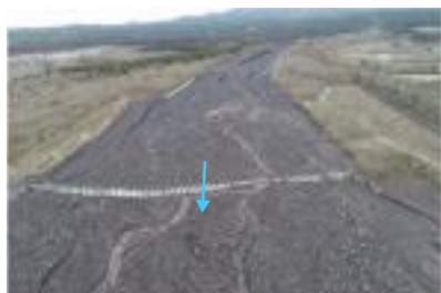
令和3年3月10日 土石流発生前
