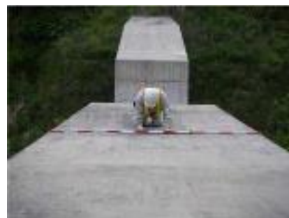
施設点検状況
