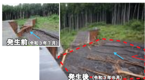
風祭第1砂防えん堤工
