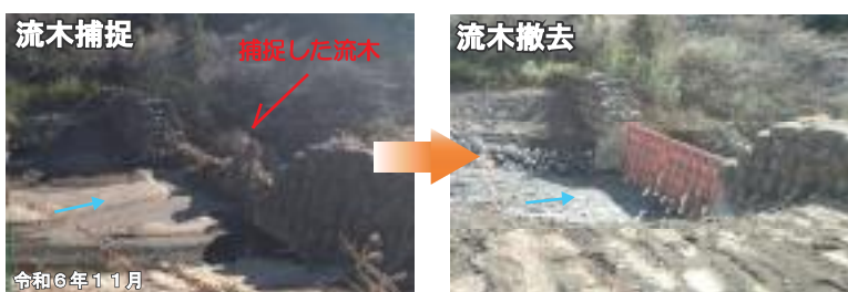
須津第1砂防えん堤工
