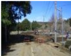
土砂流出による復旧作業
