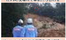
ドローンによる被災状況調査（清川新町）
