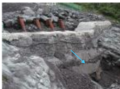
床固式低ダム工（昭和58年度施工）
