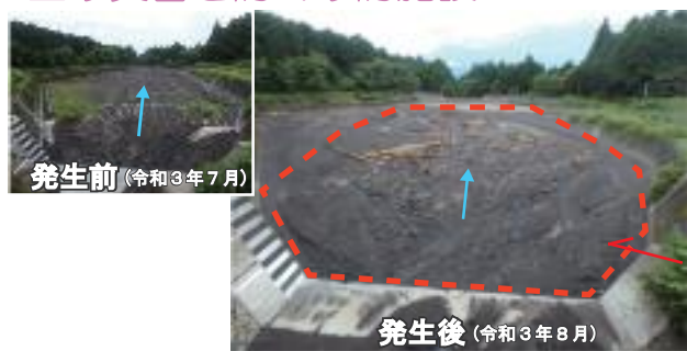
風祭沈砂地工
