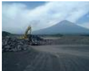
大沢川遊砂地工除石工事
