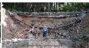
被災状況の調査 山形県庄内町清水新町
