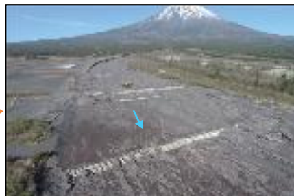
土石流発生後 第8上流床固工 堆積状況
