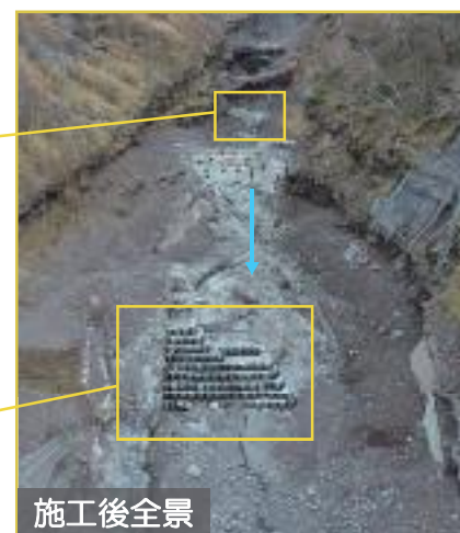
渓床対策工（2号横工） ヘリコプターによる無人化施工状況
