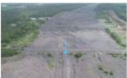
令和2年8月4日 土石流発生前
