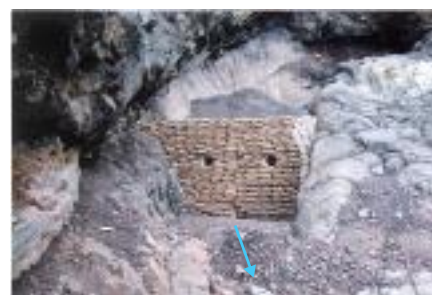
床固工（平成16年度施工）
