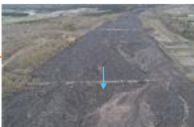
令和3年3月22日 土石流発生後
