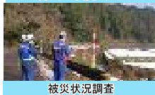
被災状況調査
