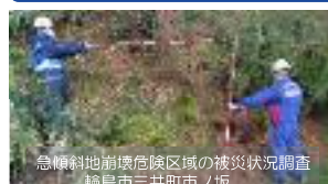
急傾斜地崩壊危険区域の被災状況調査 輪島市三井町市ノ坂
