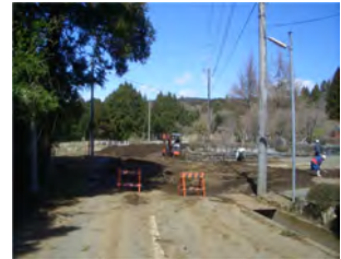
土石流による復旧作業
