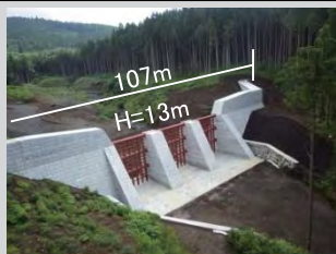
砂防えん堤工 (富士山)
