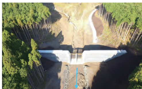
凡夫第4砂防えん堤工(令和5年度完成)
