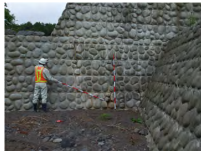
施設点検状況
