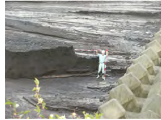
現地調査状況 (平成23年9月21日台風15号)
