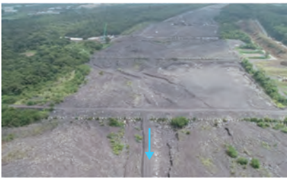
令和2年8月4日 土石流発生後
