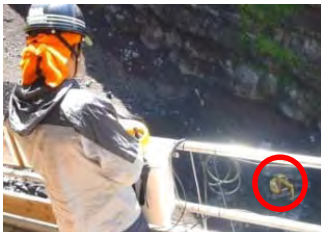
リモコン操作によるBH操作
