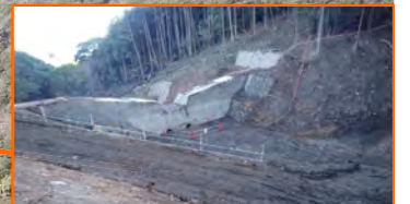
逢初川砂防えん堤(既設)の除石
