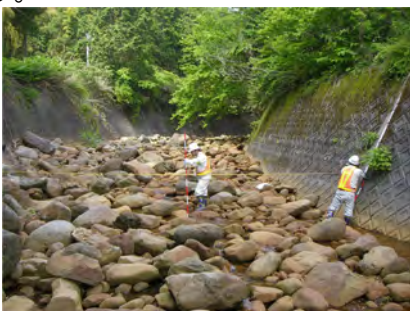
溪流点検状況
