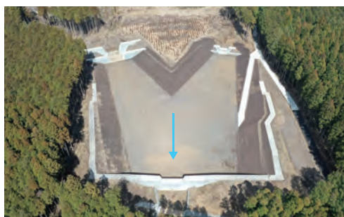
春沢遊砂土工(令和5年度完成)
