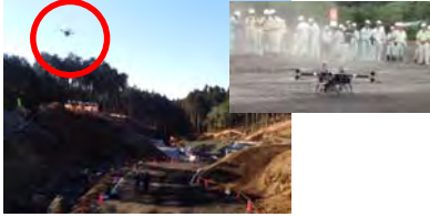
ドローンを用いた起工測量状況
