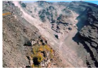
活発な土砂崩壊が続く大沢崩れ
