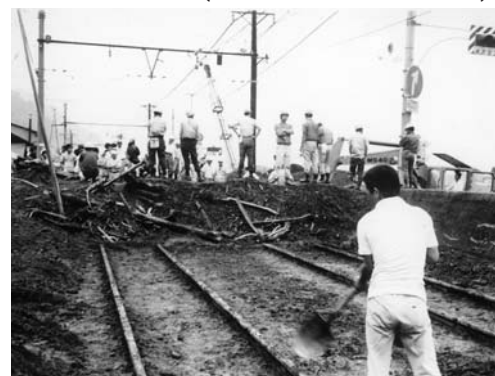
昭和49年 国鉄(JR)東海道本線 線路上に堆積した土砂の排出作業
