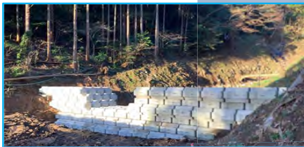
仮設ブロックえん堤
