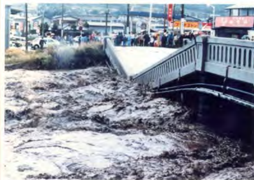
富士宮市野中東町の野中橋 (昭和54年10月19日土石流による被災状況)
