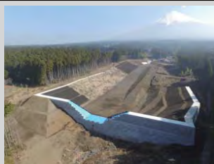
遊砂地工(沈砂地工) (富士山)
