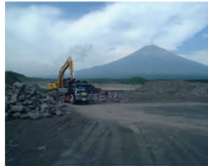
大沢川遊砂地工除石工事
