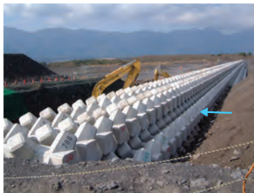
土石流発生前 第7上流床固工
