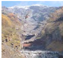
ヘリコプターを用いた施工状況
