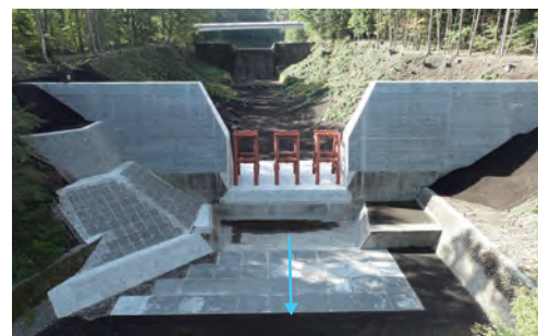
宮川7号砂防えん堤工(令和5年度完成)
