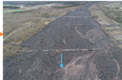
令和3年3月22日 土石流発生後
