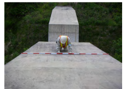
施設点検状況
