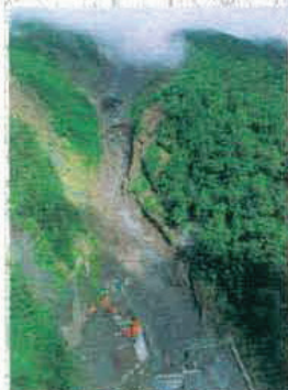
●大沢溪谷調査工事現場 提供: 読売新聞社
