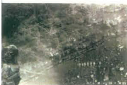
⑧大沢の渡し場です。大沢の左岸側から見たもので、行者姿の登山者の歩いているところは、毎年土石流が流れる谷底部です。
