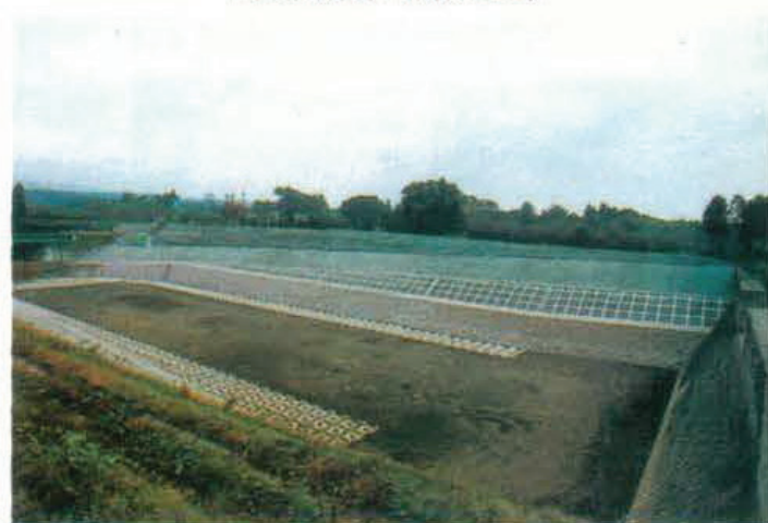
弓沢沈砂地土工工事
