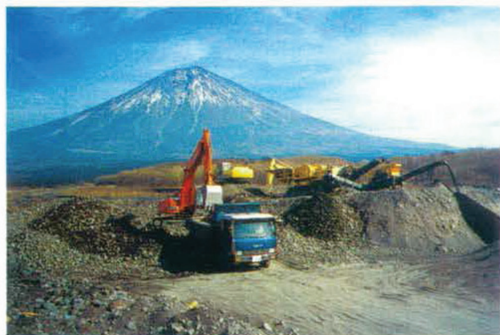
掘削、破碎、ふるい分け状況
