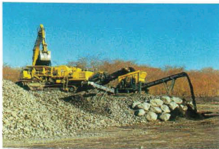
富士山大沢第7床固工除石工事
