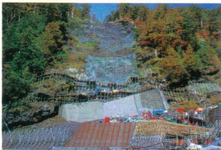
富士山源頭部調査工事
