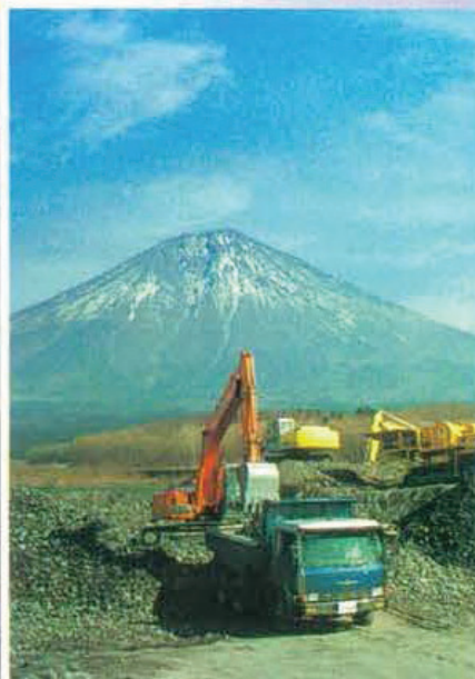
大沢川扇状地除石工
