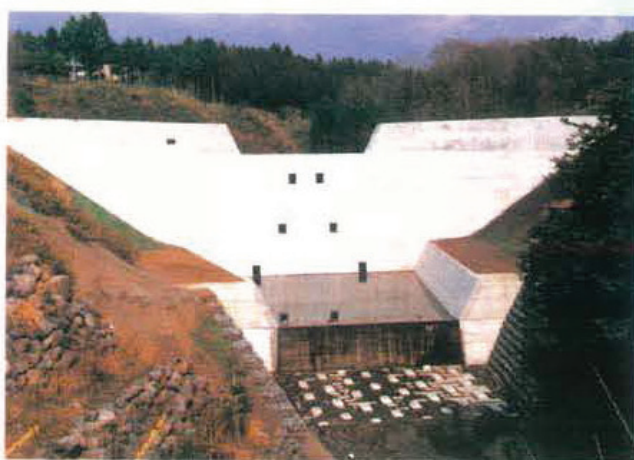
滝沢第2砂防ダム (平成10年3月完成)
