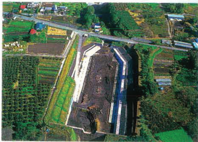
弓沢沈砂地 (平成10年11月完成)
