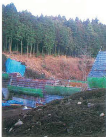
弓沢第4砂防ダム
