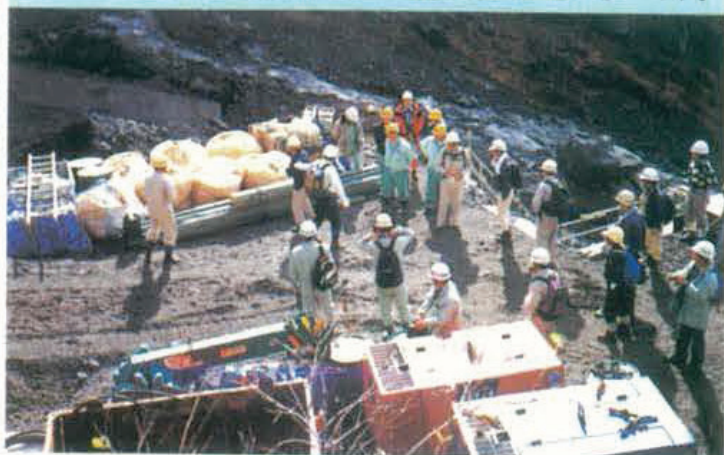
富士労働基準監督署も参加し、合同で源頭部調査工事現場の安全施設パトロール(平成10年11月13日)
