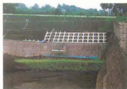
1.弓沢沈砂地工工事
