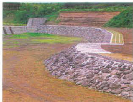
猪の窪沈砂地工護岸
