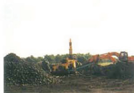
7.大沢第6床固工災害関連緊急除石工事
