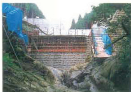
2.弓沢ダム工群工事
