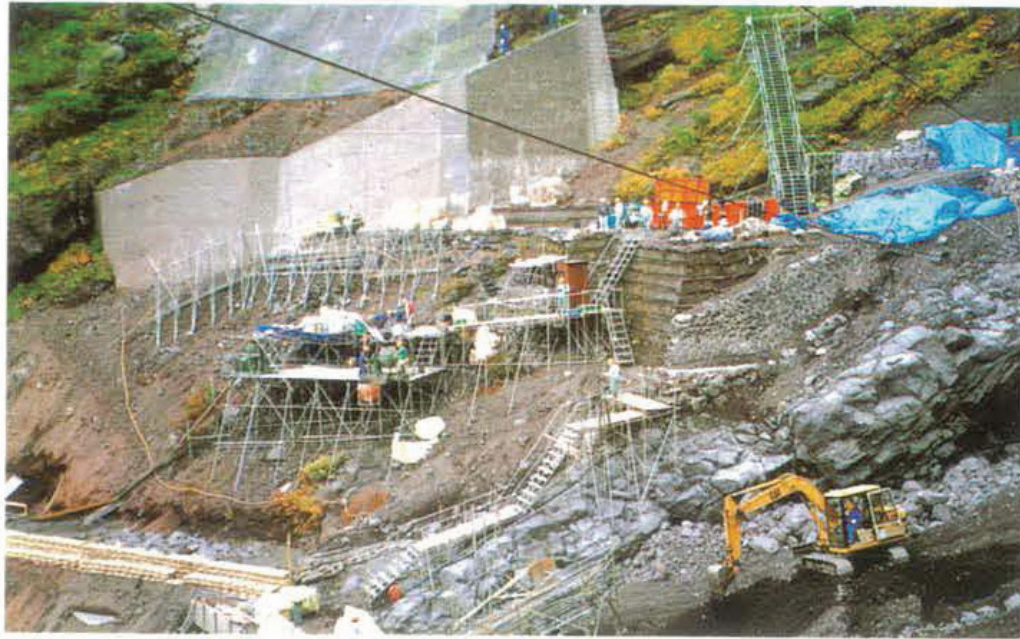
平成9年度 源頭部調査工事実施状況
