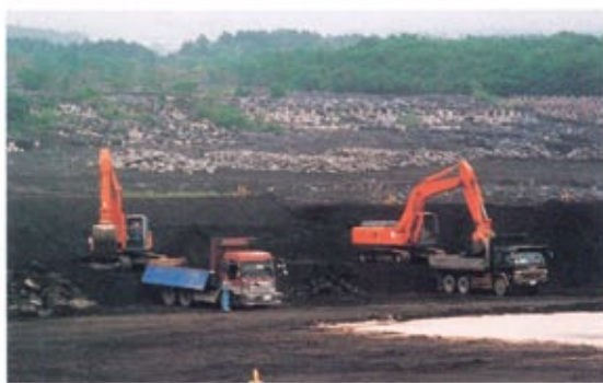
裏面地図のA地点 大沢扇状地の除石工事
