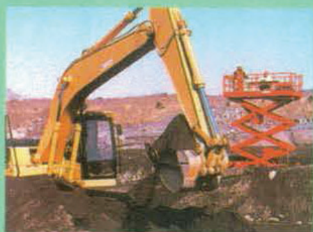
▲高所作業車より手前の無人機械をラジコン操作する実作業試験の状況。
