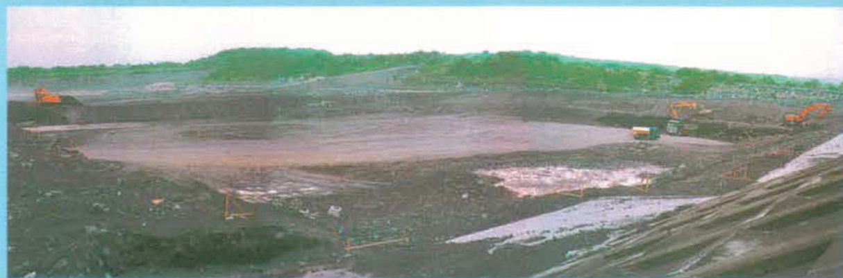
▲土砂流発生前の大沢沈砂地工……台風7号の土石流を受けて除石工を行っているところです。重機、ダンプ等と対比して広さを実感してください。
