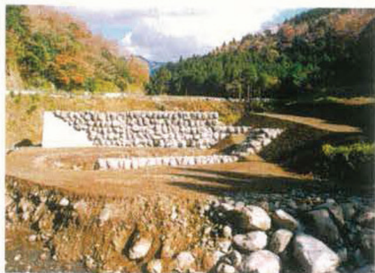
⑨須津第1ダム
