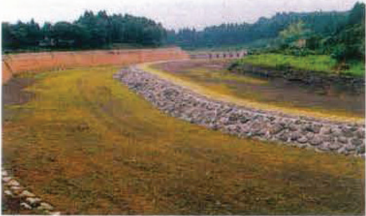
③猪窪沈砂地工
