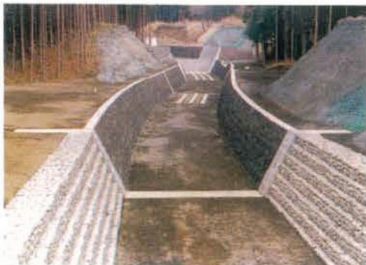
④足取床固工群
