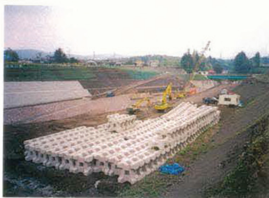
⑦弓沢沈砂地工
