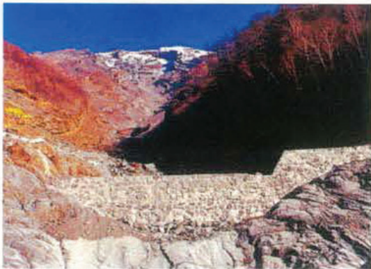
①源頭部調査工事
