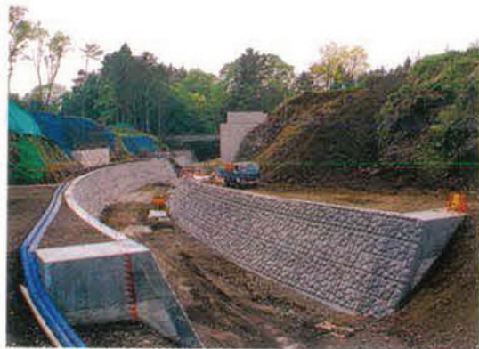
⑤大久保沢床固工群
