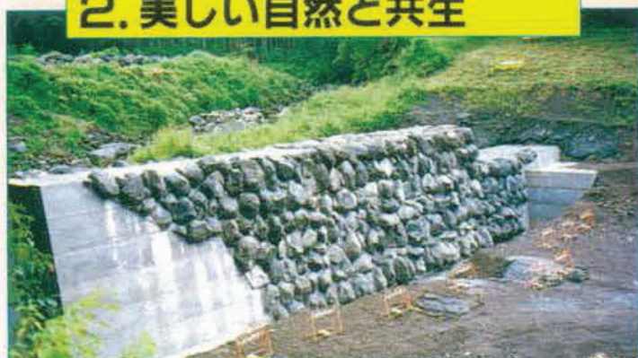
▲自然石をとり入れた須津第一砂防ダム
