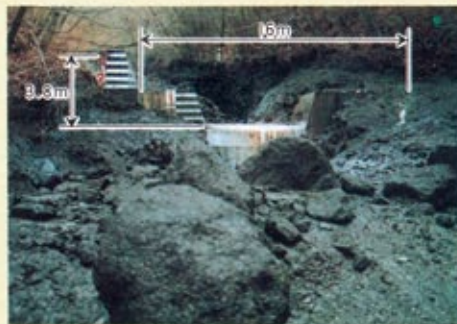
出水後の痕跡状況
