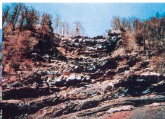
調査工事着工前(崩壊の進行とともに失われゆく植生)
