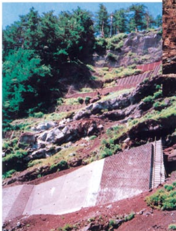
調査工事施工後(ハードな構造物の助けで回復された植生)
