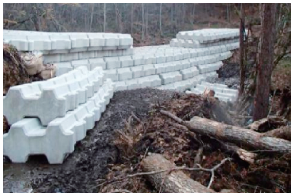
写真1 仮設えん堤の例（H26御嶽山）
