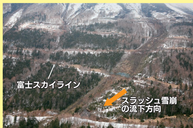
平成19年3月 富士スカイライン被災状況
