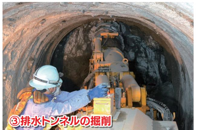
地すべりの原因となる地下水を排水するトンネル。集水ボーリングにより集めた地下水を地表へ排水します。
