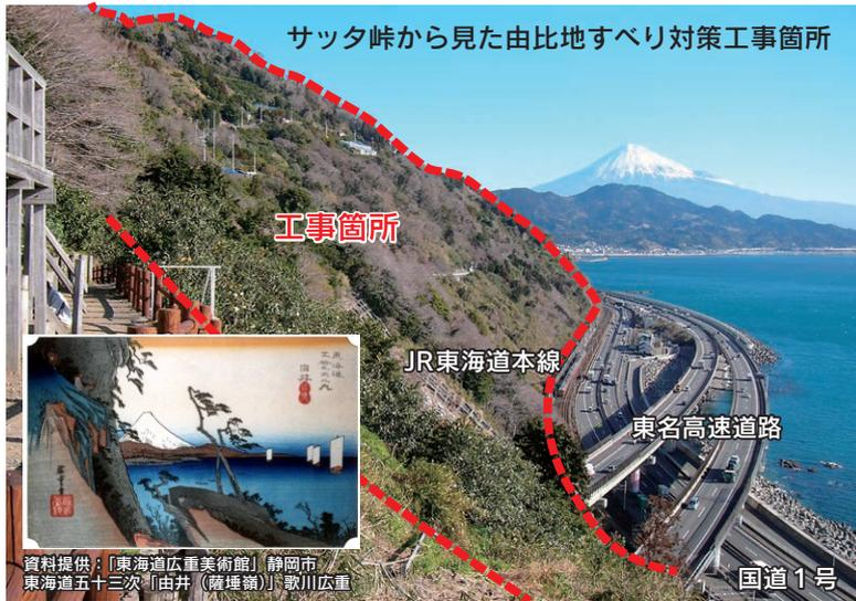
由比地区地すべり対策工事は、土の中にコンクリート杭を作る「深礎杭」やトンネル内での工事（「排水トンネル」、「集水ボーリング」など）があります。現在、施工している工事は、全て土の中で行われている工事であり、普段、見る機会がありません。
