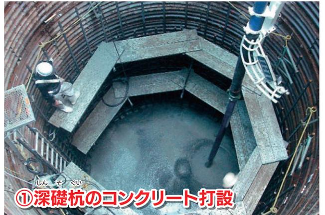
コンクリートの杭を作ることにより、地すべりにより移動しようとする斜面を押し込みます。
