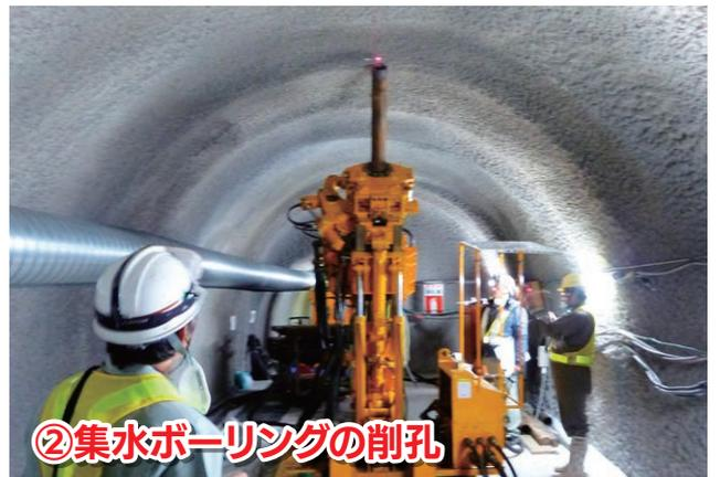
地下水が地すべりの原因となるため、トンネル内から穴を掘り、地すべり内の地下水を集めます。
