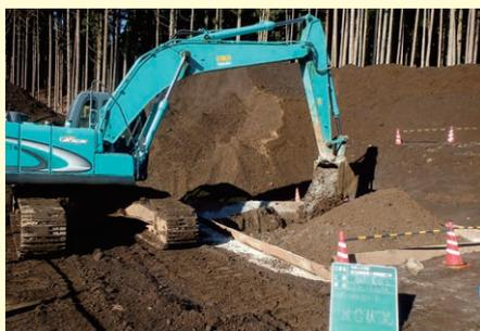
現地発生土砂とセメントの攪拌状況
