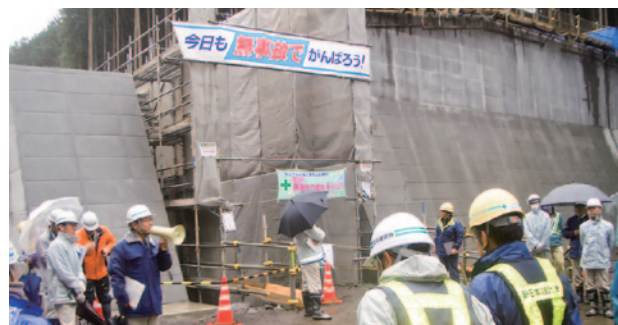
工事現場合同安全パトロール
