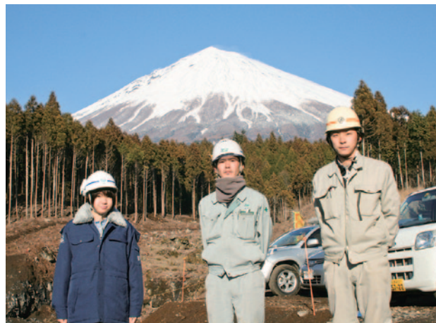
風祭第2砂防堰堤工事現場 (右から小池さん、山本さん、高岡技官)
