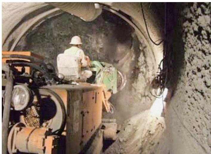
排水トンネルの施工状況
