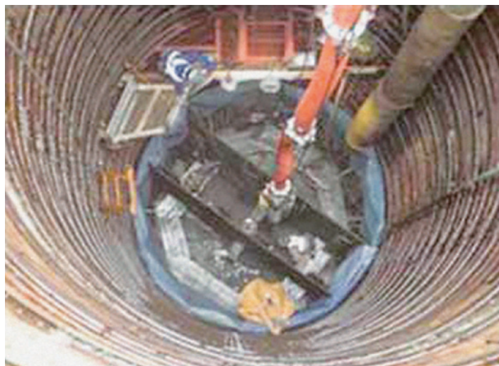
深礎杭の施工状況
