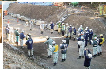
工事安全パトロール
