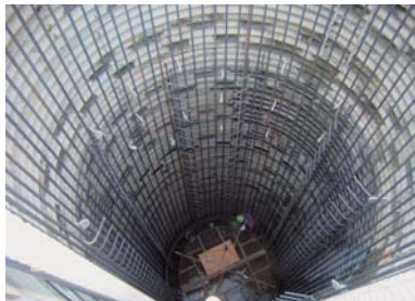
写真：深礎杭工の鉄筋組立時（左）とコンクリート打設時（右）のイメージ
