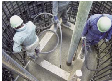
写真：深礎杭工の鉄筋組立時（左）とコンクリート打設時（右）のイメージ
