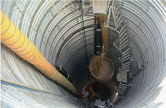
施工中の集水井（内部）
