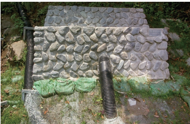
完成した横ボーリング（外観）
