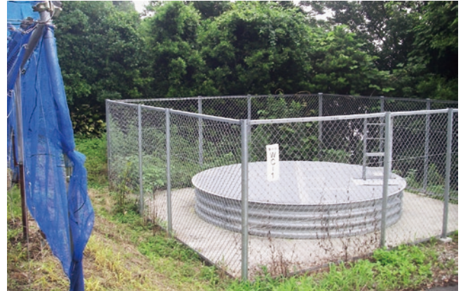
完成した集水井（地上部）
