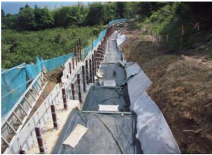
①基礎施工、遮水シート設置
