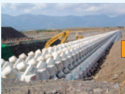
土石流発生前 第7上流床固工
