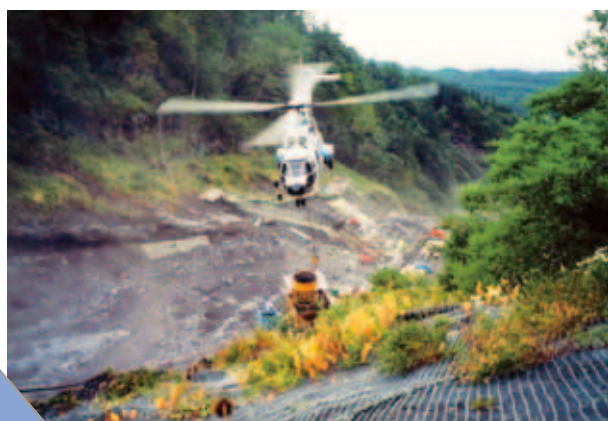
富士山源頭域調査工事
