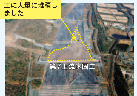
土石流発生後 大沢川遊砂地
