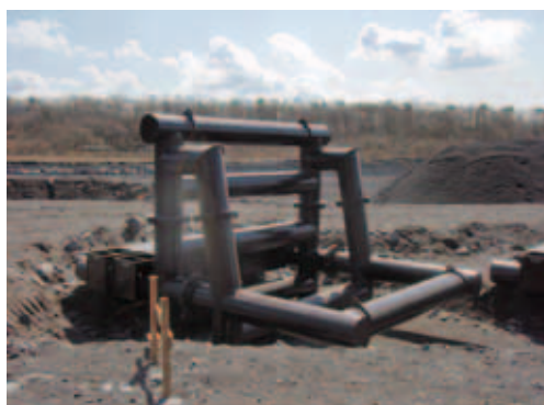
鋼製牛杵組立完了
