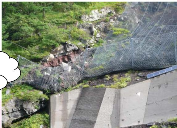
今回、効果を発揮した施設は、落石防護柵というもので、斜面崩落に伴い発生した落石等を斜面上に張ったネットで受け止めるものです。
