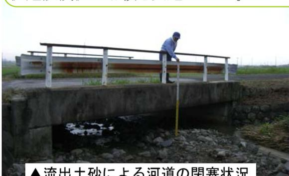
▲流出土砂による河道の閉塞状況
