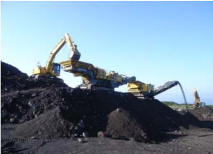
▲土砂搬出作業中(破碎作業)
