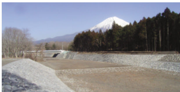
平成17年度 富士山 猪の窪沢渓流保全工事(富嶽経常建設共同企業体)
